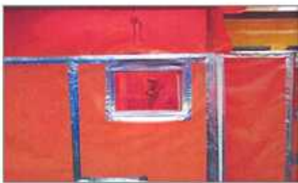
[그림 7-3] 감시창 설치 사례
