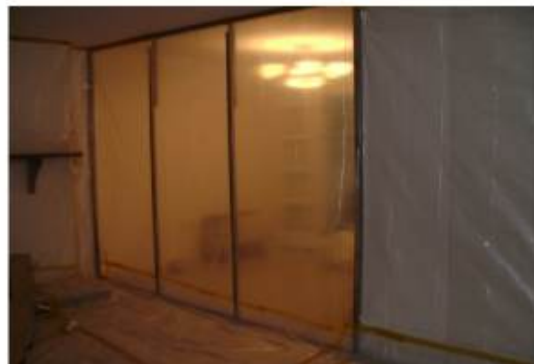
[그림 6-4] 임시벽 설치 사례
