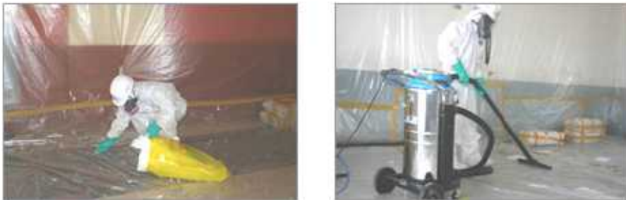
[그림 10-3] 석면함유 잔재물의 청소 모습
