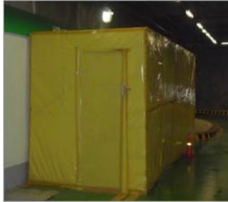
[그림 10-8] 석면폐기물 별도 보관장소 설치 예시
