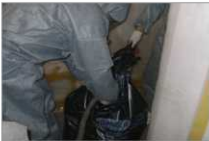
[그림 10-4] 석면폐기물 포장용기 이중 밀봉방법
