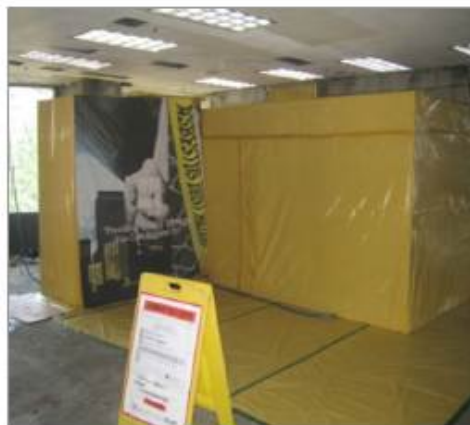
[그림 10-7] 위생설비 측면에 설치한 석면폐기물 반출구 예시
