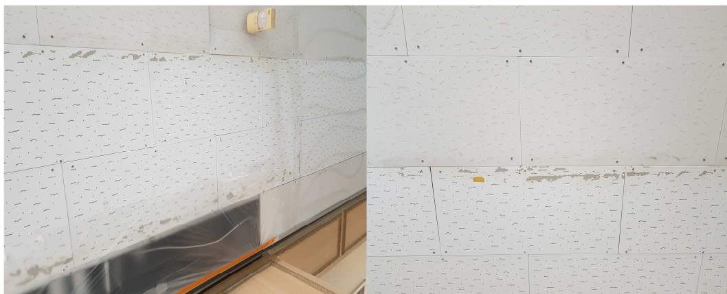
< 부분철거에 의해 작업이후 비닐철거과정에서 테이프에 의해 석면텍스 표면이 훼손되어 코팅된 부분이 떨어져 나간 복도석면텍스, 2018년 성남지역 학교>
